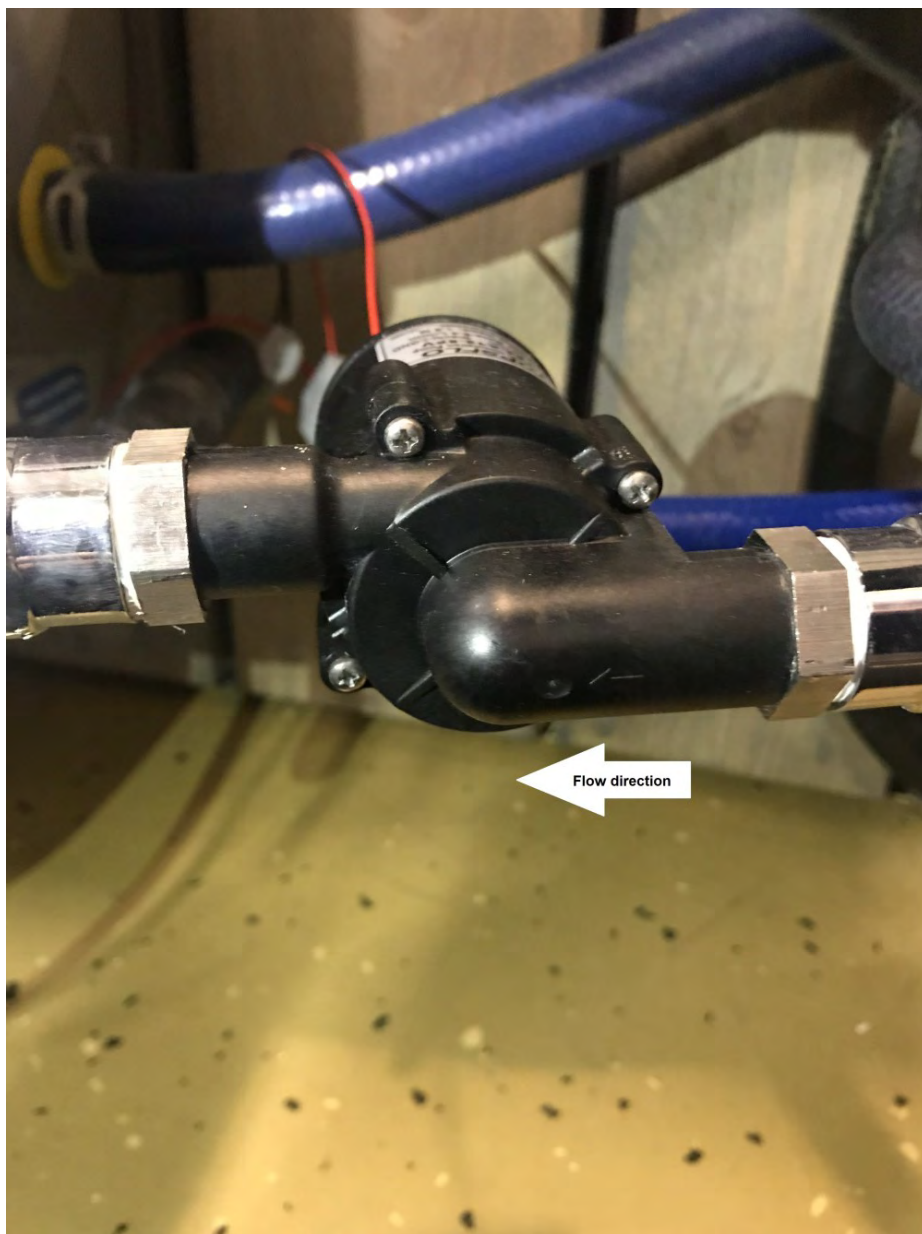
Der seitlich an der Pumpe angebrachte Pfeil zeigt die Strömungsrichtung an.
