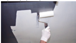
Apply antifouling over primer or tiecoat
